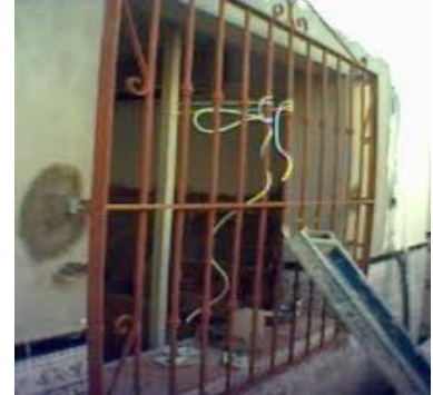
Colocación de reja de acero
