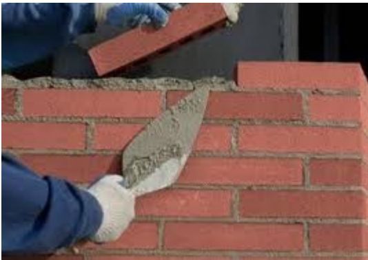
Mortero de cemento para unir ladrillos (generalmente 6 parte de arena y 1 de cemento)
