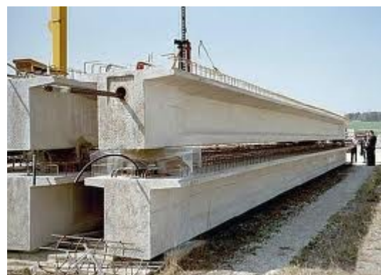
Vigas de hormigón pretensado, se utiliza por ejemplo en la construcción de puentes
