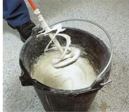
Mezcla de yeso con agua, el yeso se utiliza en molduras, escayolas, etc.
