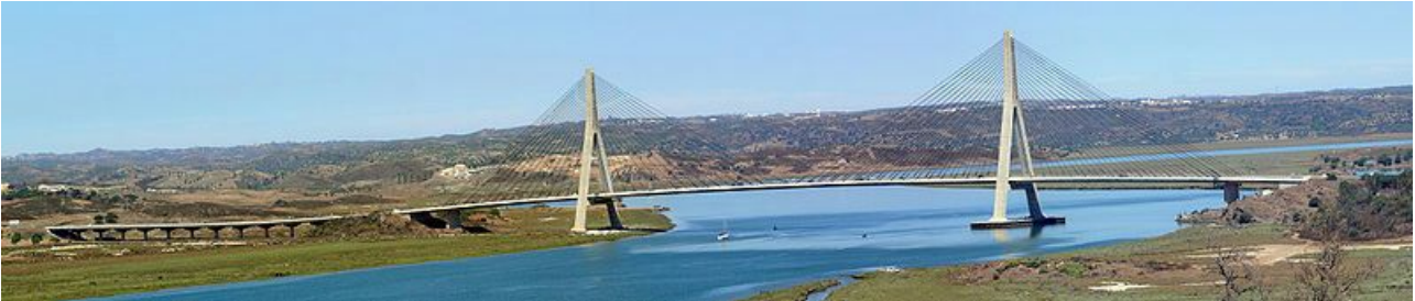
Puente Internacional del Guadiana, en la frontera entre España y Portugal.
